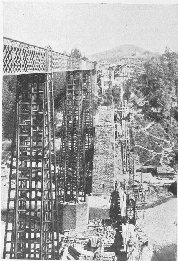
Abb. 1. Uebersicht der Eisenbahn-Sitterbrücken vom linken Ufer.
