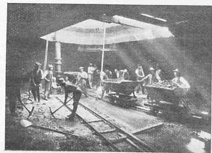
Abb. 3 und 4 Senkkasten für den Flusspfeiler der neuen Sitter- brücke der S. B. B. links von oben, rechts von innen gesehen.
