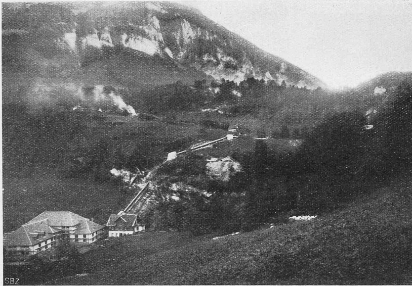
Abb. 3. Rohrleitung und Maschinenhaus des Lungernsee-Kraftwerks, oberhalb Giswil.
