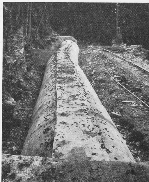
Abb. 5. Das fertige Eisenbeton-Druckrohr, noch unüberdeckt.
