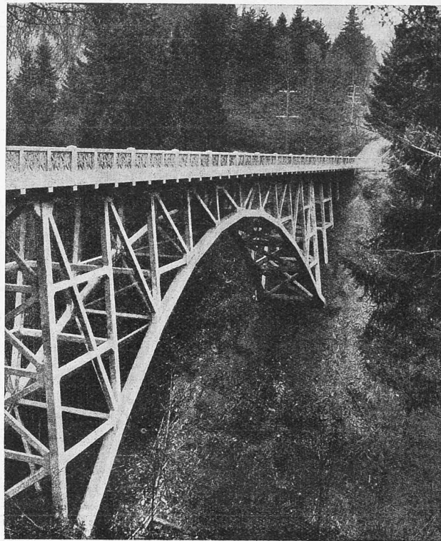
Alexander Avenue Viadukt bei Portland, Oregon.
