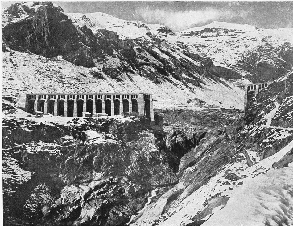
Abb. 7 (oben) Ansicht von Süden
