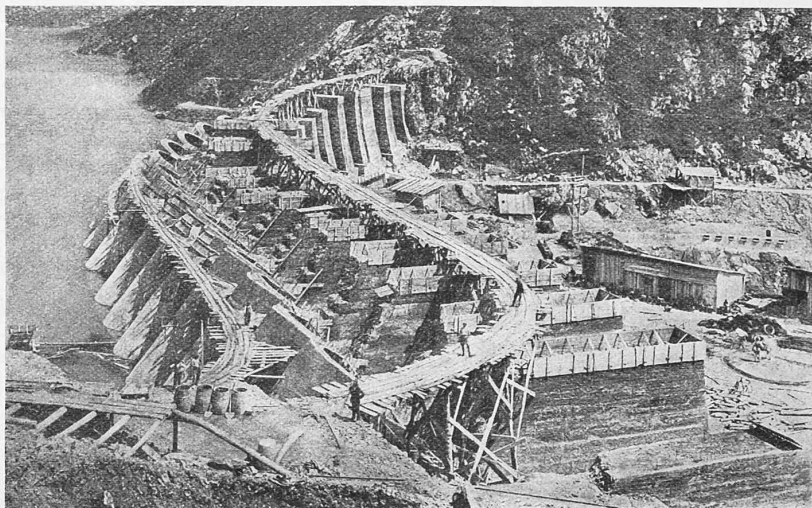
Abb. 2. Blick auf die Baustelle gegen die linke (östliche) Talseite.
