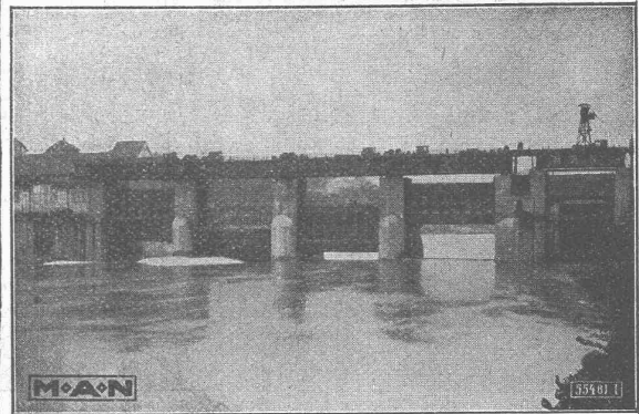
Wehranlage im Rhein, Kraftwerk Laufenburg
