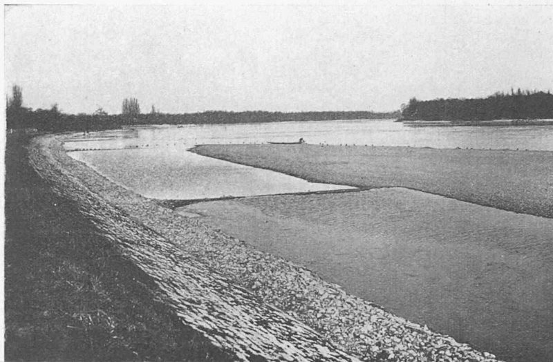
Abb. 6. Unterbindung einer Nebenrinne durch Bühnen-Einbau.
