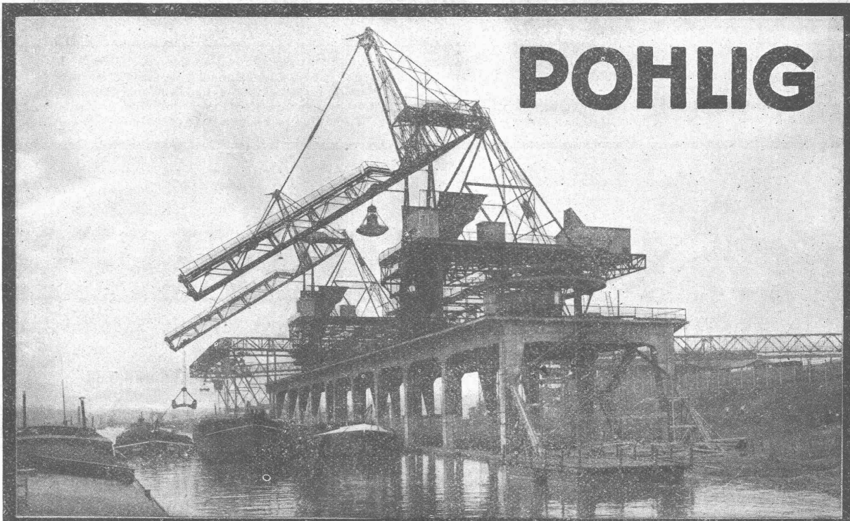
Größte Elektrohängebahnanlage der Welt. Stündliche Leistung 500t. Bild 1: Uferentlader mit Kaistrocke der Elektrohängebahn
