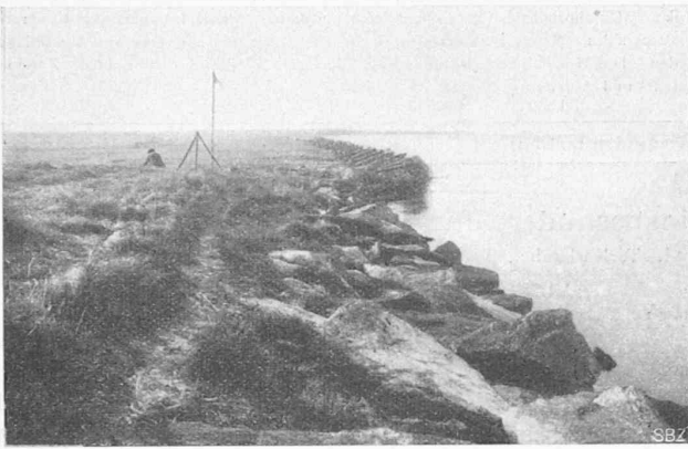
Abb. 3 und 4. Wolfsche Wand an der Tessinmündung in den Langensee, zur Verlandung des links abbiegenden Flussarms (vergl. Abb. 1 und 2).
