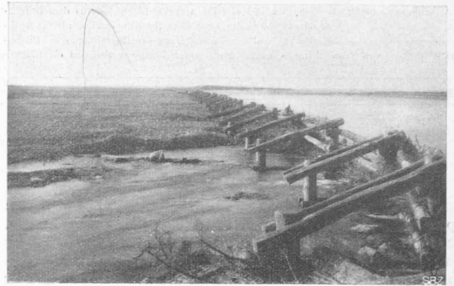
Abb. 3 und 4. Wolfsche Wand an der Tessinmündung in den Langensee, zur Verlandung des links abbiegenden Flussarms (vergl. Abb. 1 und 2).
