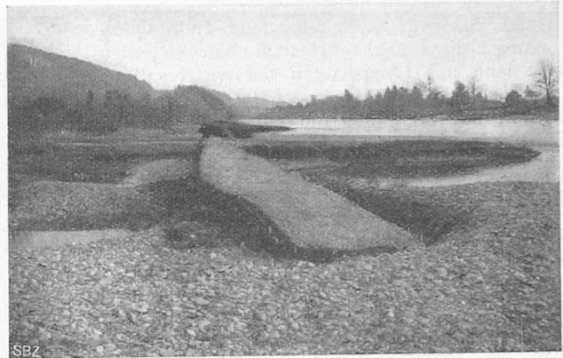
Abb. 11. Anhängsel landwärts des Buhnenkopfs: Ablagerung.
