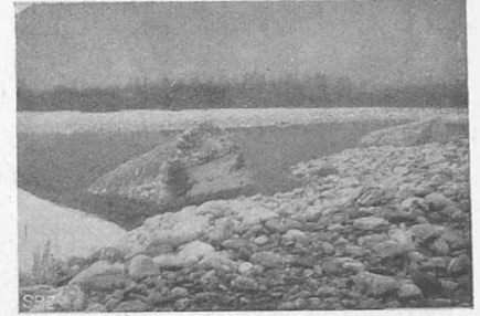
Abb. 8 und 9. Isolierte Beton-Bühnen in der Verzasca bei Tenero (Kt. Tessin).
