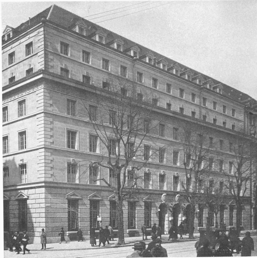
FASSADE AN DER BAHNHOFSTRASSE
