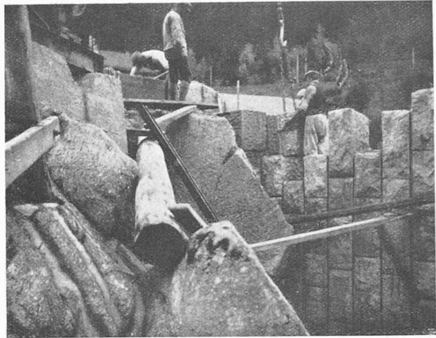
Abb. 25. Einsetzen der Gewölbesteine mittels Derrick.
