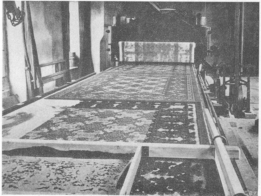
Abb. 6. Der Schablonentisch für die Herstellung von Inlaid-Linoleum.
