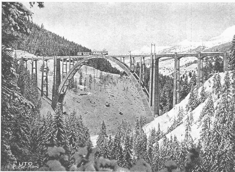
Langwieser Viadukt der Chur-Arosabahn (Läng- 237 m)
