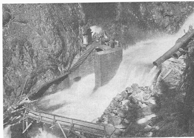
Abb. 45. Fellibach-Staumauer bei Hochwasser.
