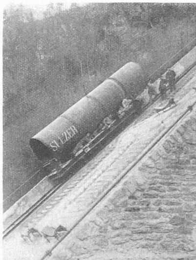
Abb. 54. Rohr auf Seilbahnwagen (23. XI. 20).
