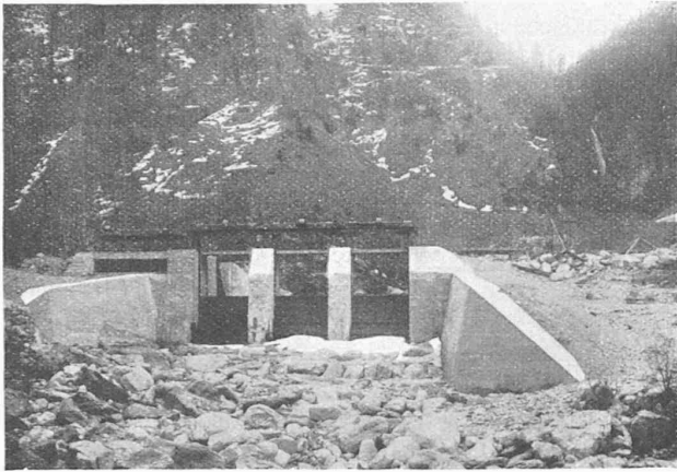
Abb. 69. Etslibachfassung von der Unterwasserseite (6. IV. 25).
