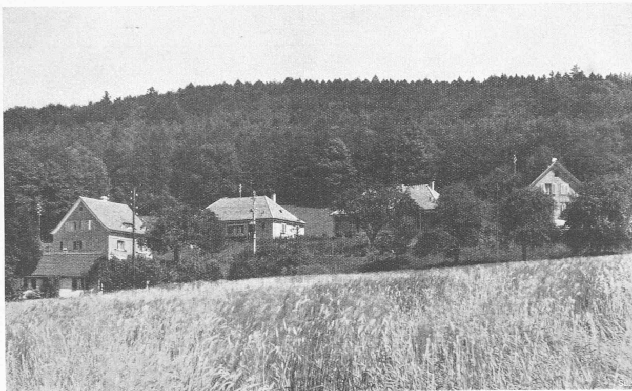
Abb. 1. Gesamtbild aus Westen, im Hintergrund der Zürichbergwald.
