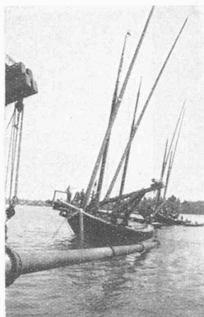
Fig. 7. Tronçon de conduite en voie d'immersion.
