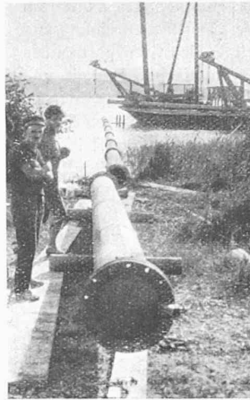
Fig. 11. Lançage par flottaison du tronçon de rive.
