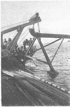
Fig. 9. Extrémité de la conduite. Support de la crépine.
