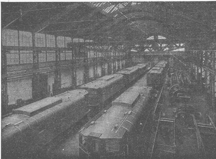
Lokomotiv-Montagehalle mit elektrischen Lokomotiven für Südafrika
