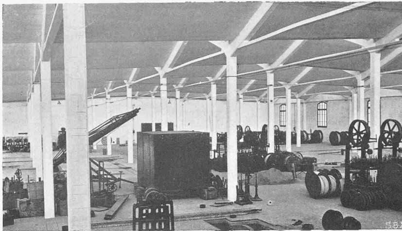
Kabelfabrik von Pirelli in Villa- nueva, Spanien
