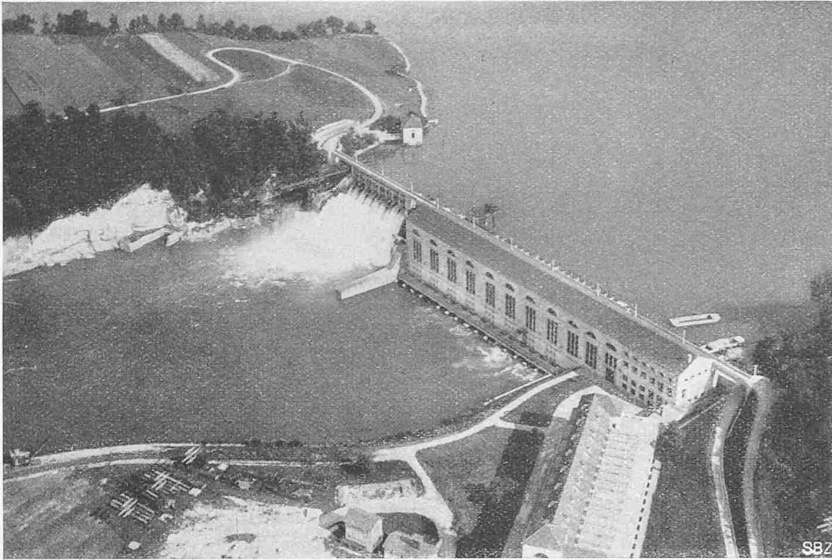
Abb. 51. „Ad Astra-Aero“-Fliegerbild“ des Kraftwerks Mühleberg, aus NW.
