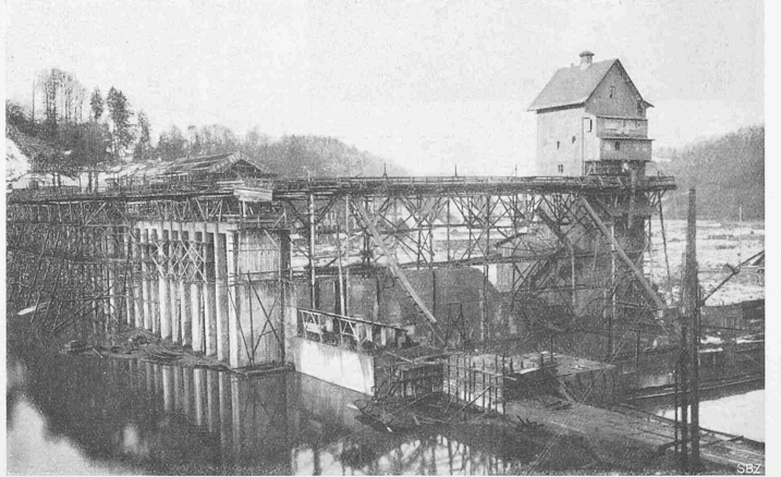
Abb. 43. Desgl. am 21. Nov. 1919; Aare gestaut, Caisson XI eingeschwommen, Baugrube III geschlossen.
