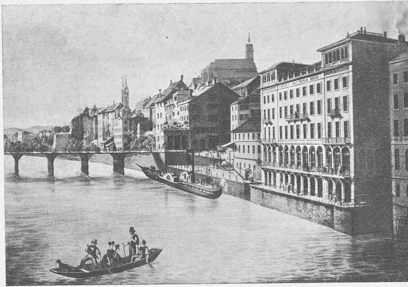
Abb. 1. Die Basler Schifflände vor 80 Jahren. Nach einem alten Stich.
