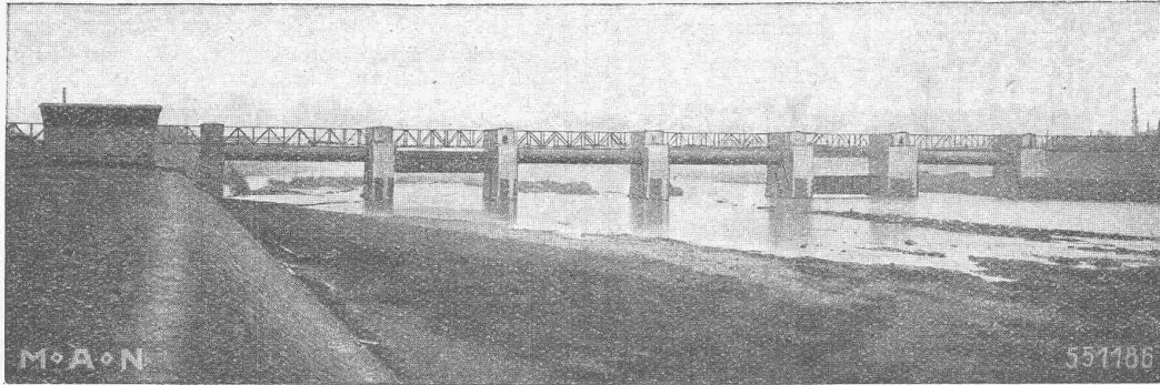
Wehranlage im Neckar, Wieblingen bei Heidelberg.
