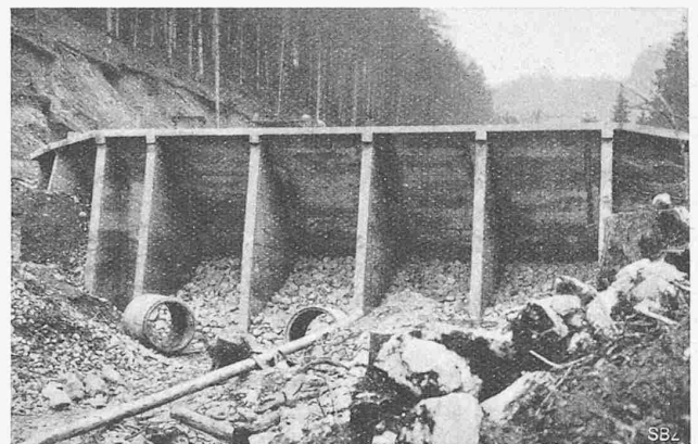
Abb. 4. Stauwand, von der Luftseite gesehen.
