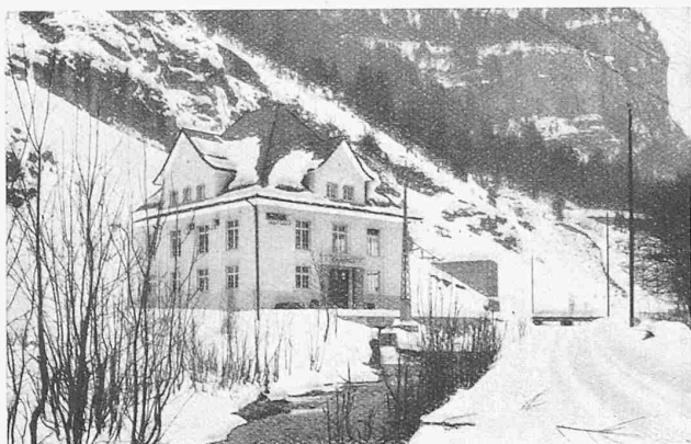
Abb. 8. Maschinenhaus des neuen Elektrizitätswerks Näfels.
