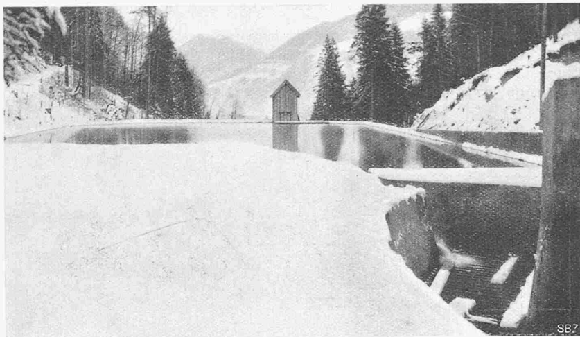
Abb. 5. Ausgleichbecken. Rechts Einlaufrechen der Haslenbach-Umleitung.
