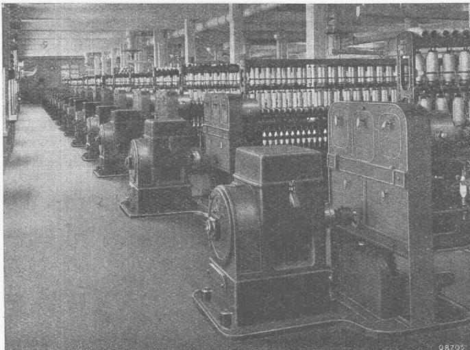
Einzelantrieb von 16 Baumwollringspinn-Maschinen
