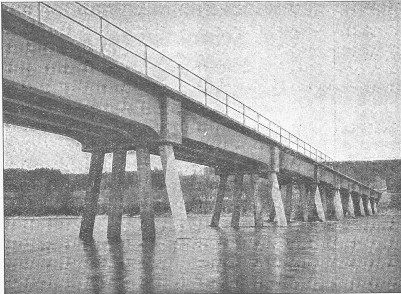
Eisenbahnbrücke über die Aare bei Däniken. Erste schweizerische Pfahljochbrücke in Eisenbeton.
