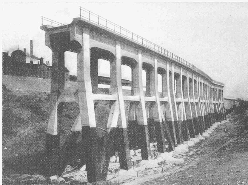
Abb. 4. Stockwerkrahmen der Stuttgarter Geleisekreuzungen, vor der Einfüllung.
