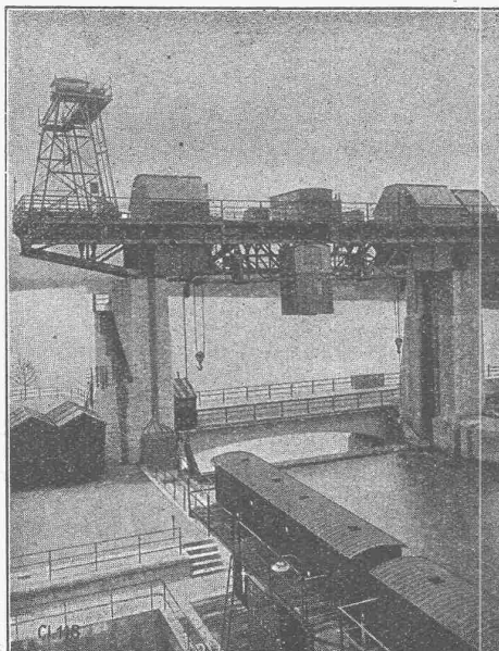
Fahrbarer Montagebockkran, Dammbalkentransportkran und Doppelwindwerke, Kraftwerk Augst-Wyhlen.
