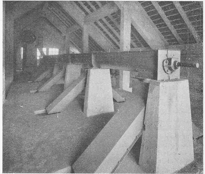
Abb. 3. Verteilungsschnecke im Dachboden. Im Hintergrud der Elevator.
