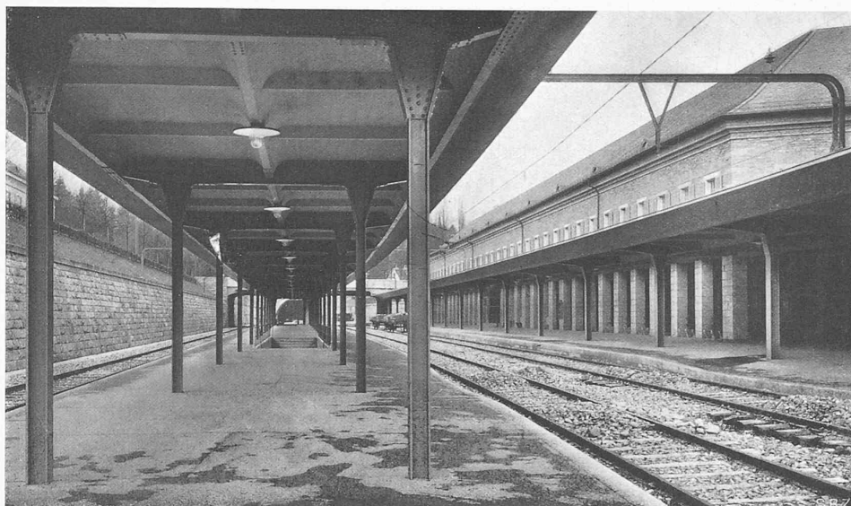
Abb. 24. Bahnsteigdächer des Bahnhofs Enge, gegen Norden gesehen.
