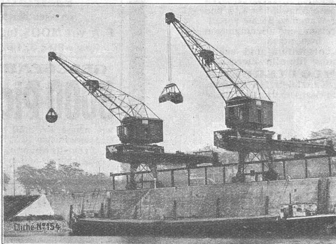
Hafenkrane für Greifer- und Stückgutbetrieb.
