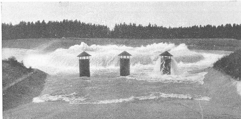
Abb. 3. Blick in der Rohraxe auf das Energievernichtungsbecken in voller Tätigkeit.
