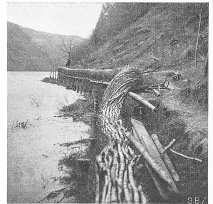
Abb. 8. Ufersicherung mittels Senkwalzen, Abrollen der Walze.
