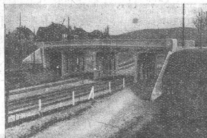
Römerstrassenbrücke in Winterthur
