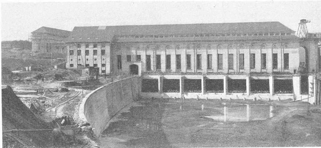
Abb. 46. Blick auf Einlaufbecken und Maschinenhaus. — Aufnahme vom 23. März 1920.
