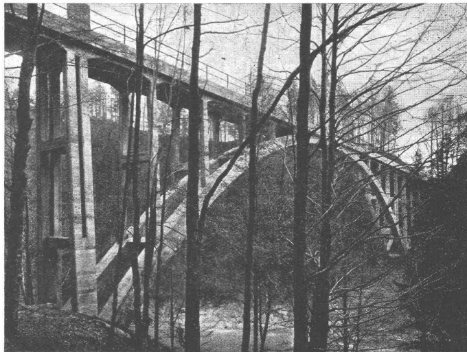
Eisenbetonbrücke über die Sihl bei Schindellegi.
