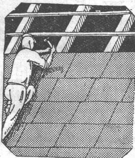
**Diana-Unterdachplatten:** Zweckmässigstes Dachunterkonstruktionsmaterial für Neu- und Umbauten. / Bei bestehenden Bauten können die Dianaplatzen *ohne Dachumdeckung* leicht und rasch vom Dachinnern aus angebracht werden.
