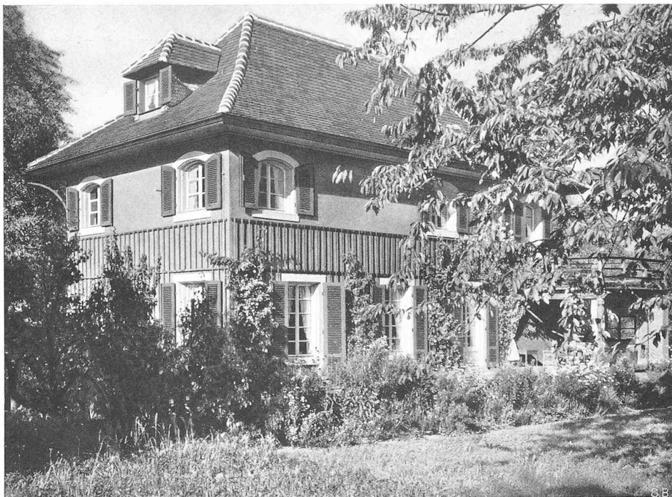
WOHNHAUS DES ARCH. MAX KOPP. AM HOHENRAIN, KILCHBERG OBEN AUS SÜDWEST, UNTEN AUS SÜDOST, SEESEITE
