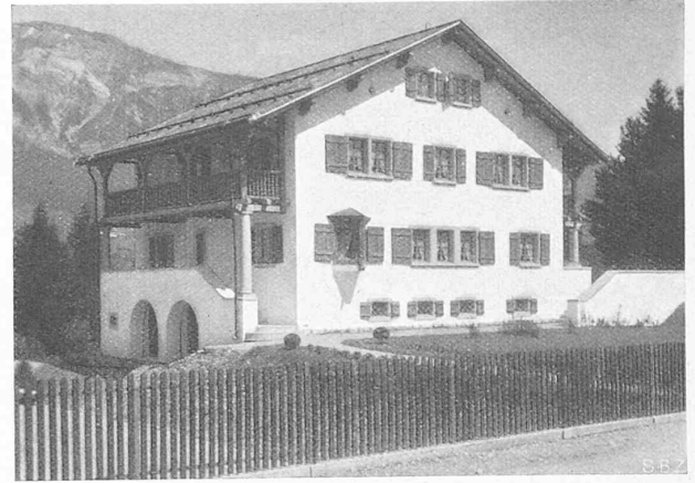
Abb. 6. Haus Dr. E. Misslin in Flims, aus Südwest.
