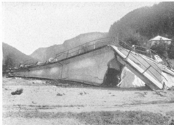
Abb. 11. Linke Brückenhälfte (III), flussabwärtige Seite.
