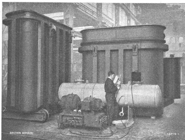
Mit Brown Boveri Lichtbogen-Schweißgruppen elektrisch geschweißte Groß-Transformatorenkessel.
