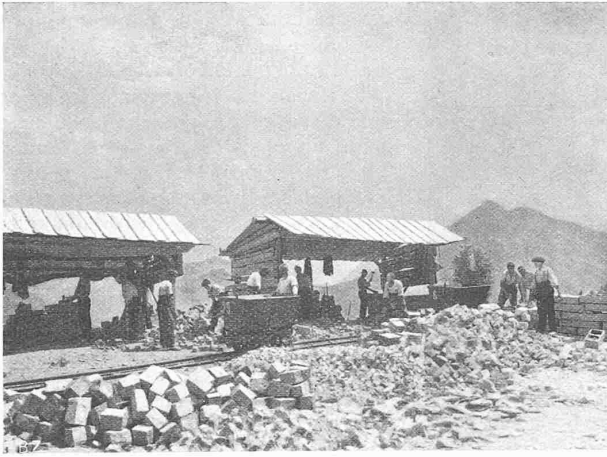
Abb. 5. Herrichten der Pflastersteine auf den Terrassen.
