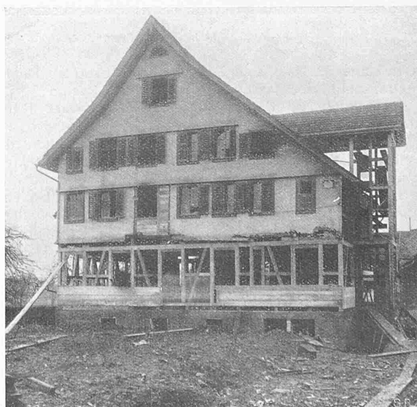
Abb. 5. „Männerhaus“ in Baar, verschoben, gedreht und gehoben.
