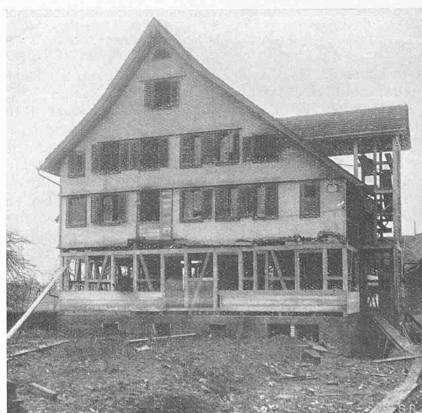
Abb. 5. „Männerhaus“ in Baar, verschoben, gedreht und gehoben.
