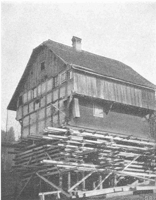
Abb. 3. Hebung um 5 \times \text{rd. } 2 \text{ m} an der steilen Böschung.
