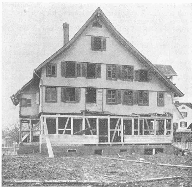
Abb. 6. Das „Mennerhaus“ in Baar mit neuem Unterbau.
