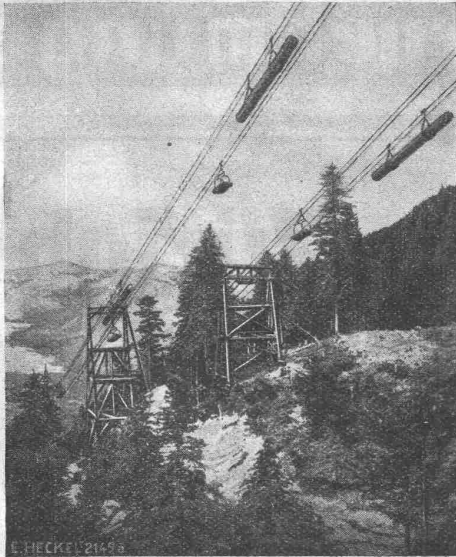
Drahtseilbahn „HECKEL“ zum Holztransport im Gebirge.
