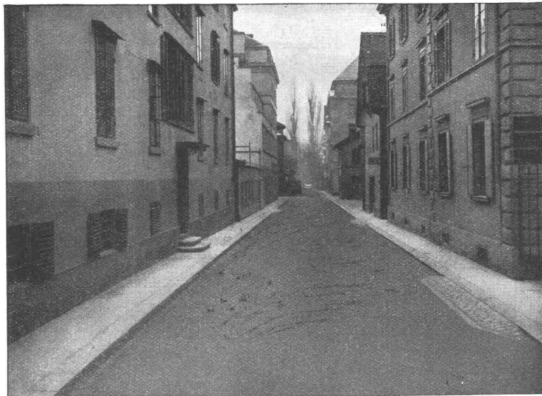
GLARNISCHSTRASSE ZÜRICH Walz-Asphalt: Topeka, 6 cm stark
