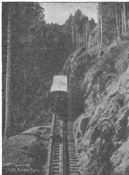
Seilbahn Niesen, I. Sektion, maximale Steigung 66 %.
