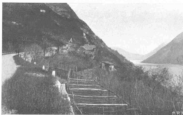
Abb. 18. Zufahrt zur Abzweigung A der oberen Strasse.
