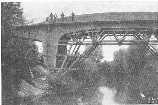
Fig. 4. Le nouveau pont de Labarthe avec son cintre.
