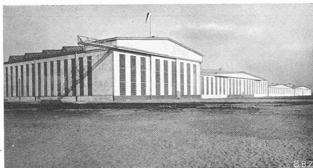
Abb. 22. Die grossen Flugzeughallen aus Südwesten.
