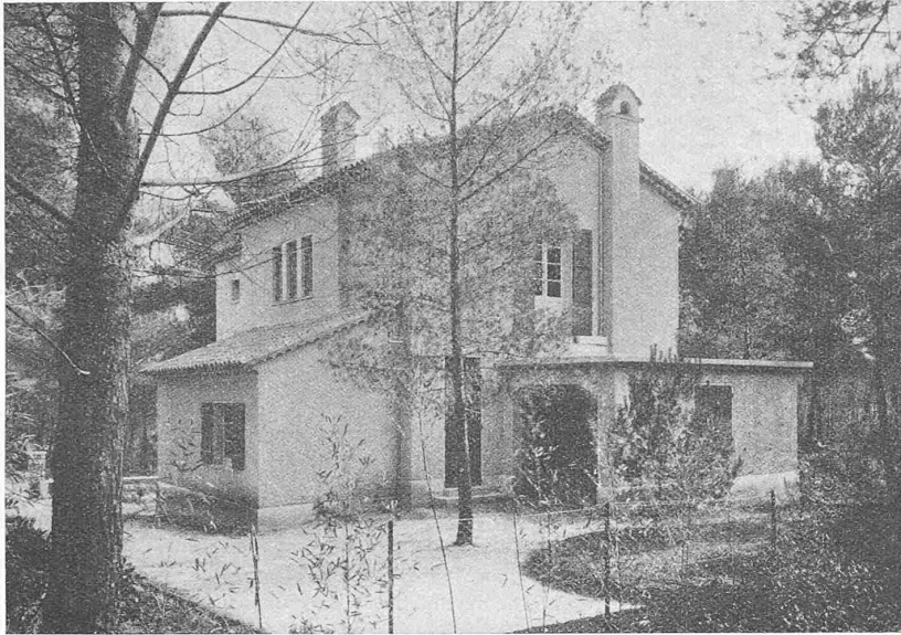
Abb. 8. Nordecke des Hauses F. mit Kücheneingang und Garage.
